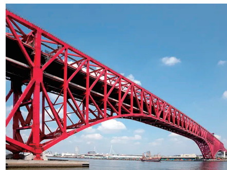
写真-2 代表的なゲルバートラス橋（港大橋開通50年特設サイトより）
