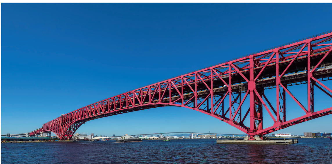
写真-1 港大橋の全景
