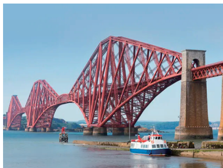
写真-2 代表的なゲルバートラス橋（港大橋開通50年特設サイトより）
