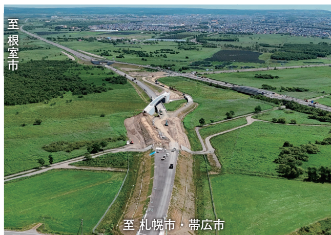
写真①：道東自動車道工事中の状況（釧路西 IC）
