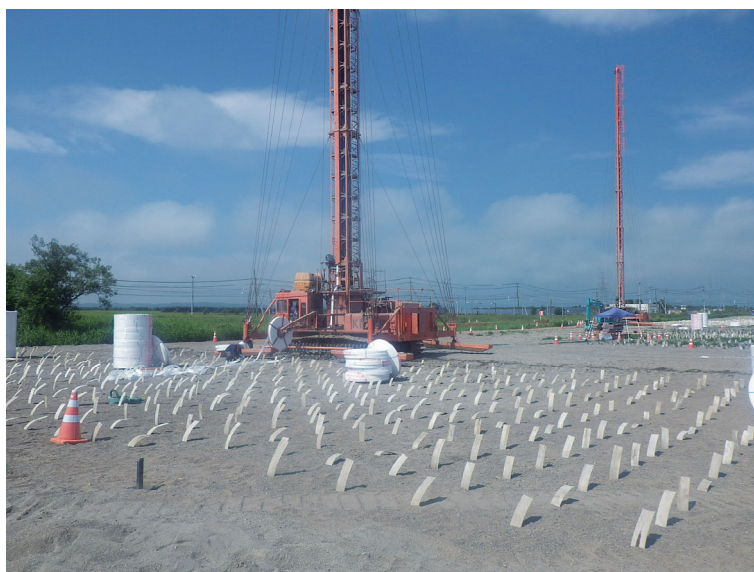
写真③：軟弱地盤対策工（バーチカルドレーン工法）
