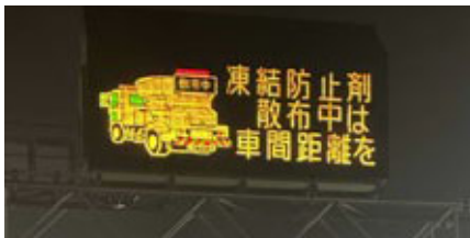
写真5 道路情報表示板（注意喚起）
