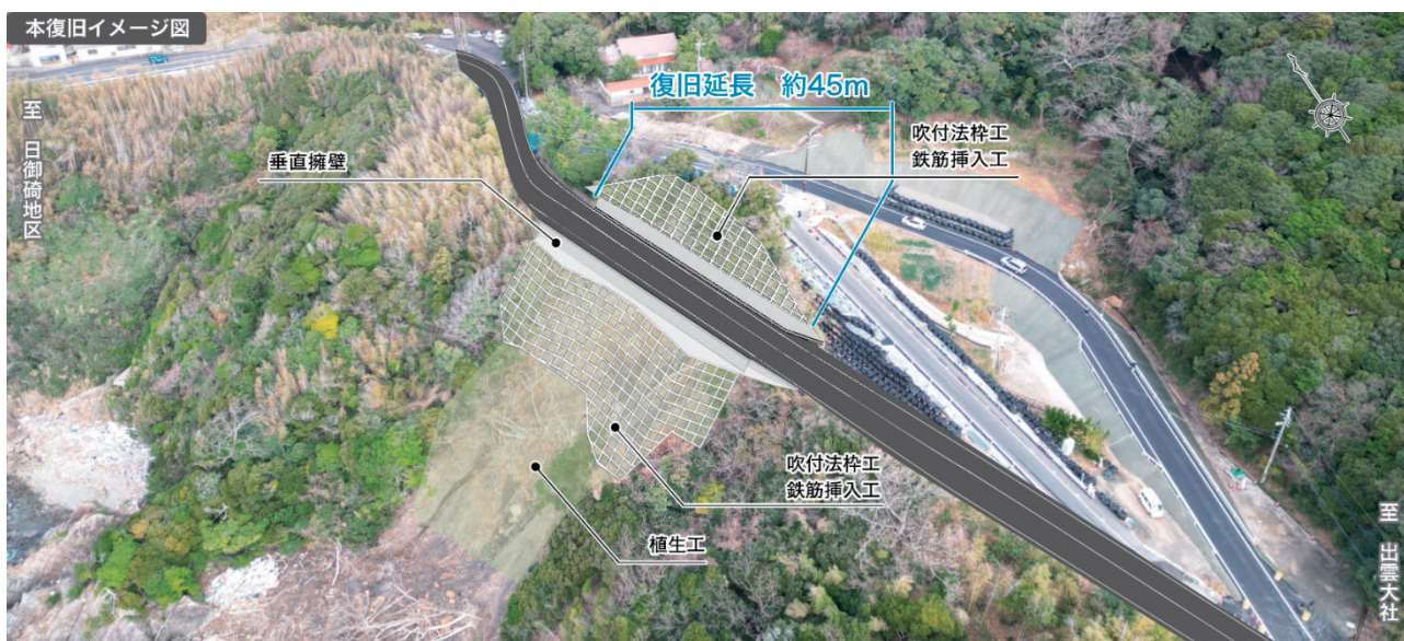
写真8 復旧工法の概要
