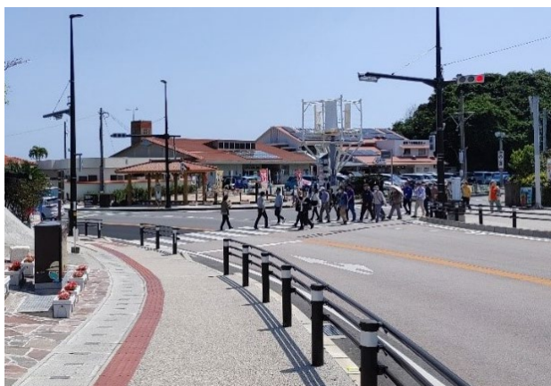
【無電柱化・歩道整備後②】
