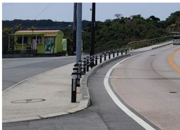
歩道整備後（新設した歩道・車両用防護柵）
