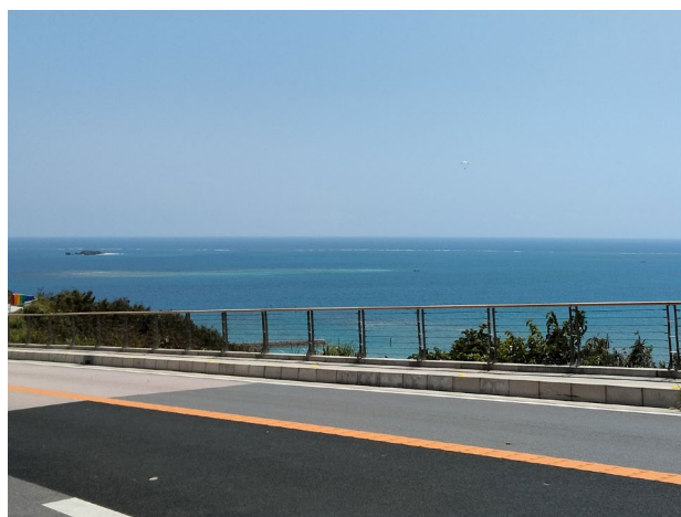
歩道整備後（ワイヤータイプの転落防止柵）
