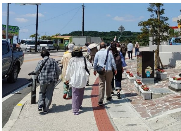
歩道整備後（拡幅した歩道（歩道幅員 W=2.5m））
