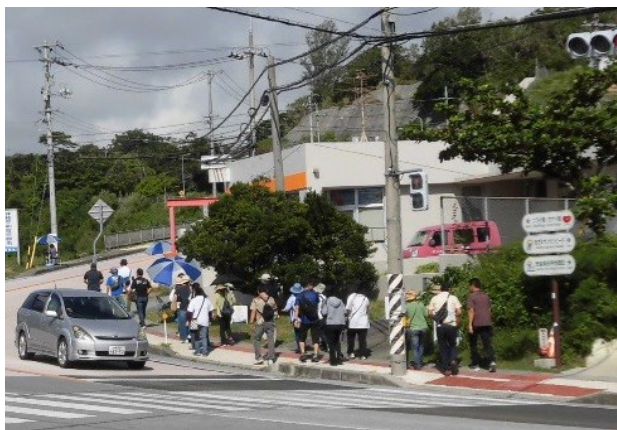
歩道整備前（歩行者の通行状況）
