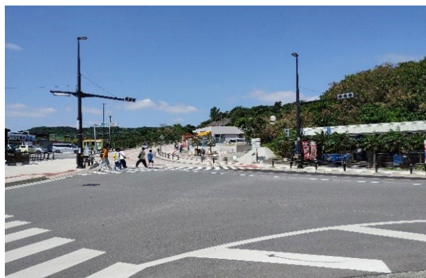
【無電柱化・歩道整備後①】
