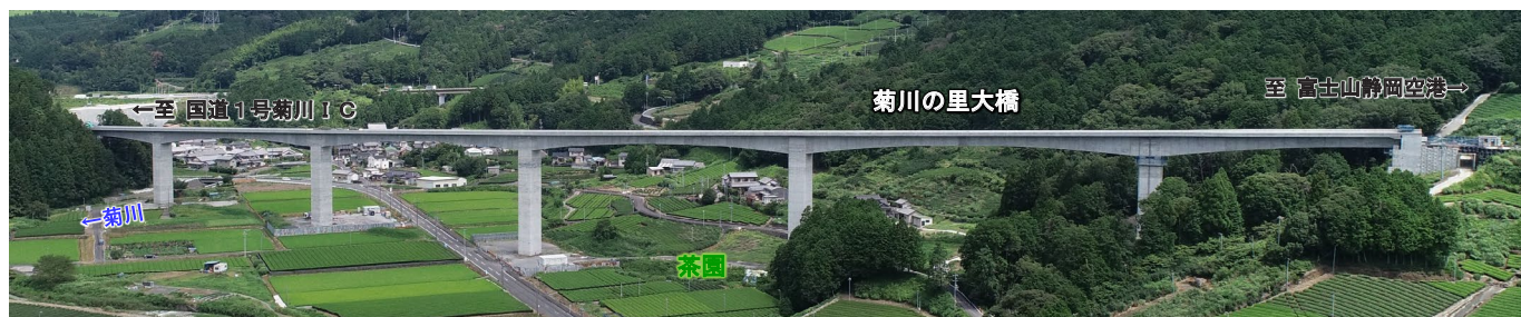
写真 菊川の里大橋 上部工工事 完成時の状況
