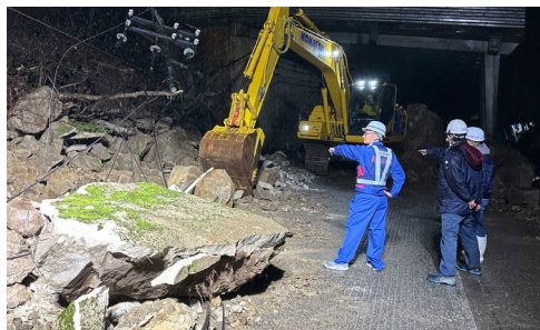
道路啓開作業の様子（石川県輪島市）
