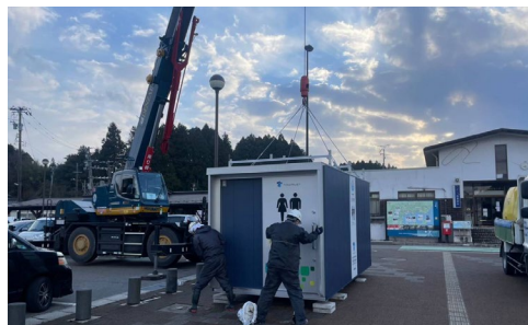
トイレコンテナ設置作業の状況（「道の駅」あなみず（石川県穴水町））
