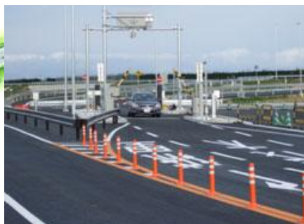
水戸北スマートIC（常磐自動車道）
