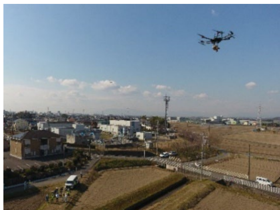
図ー5 ドローン測量状況
