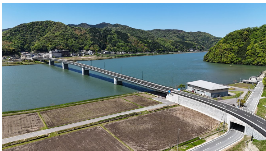
【県道 豊岡竹野線 城崎大橋 全景】
