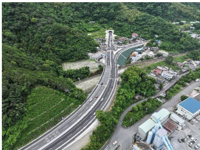
写真③：梅田冷水トンネル北側（令和7年6月）
