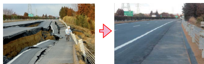
被災直後の様子 水戸 IC～那珂 IC 間盛土のり面の崩壊
