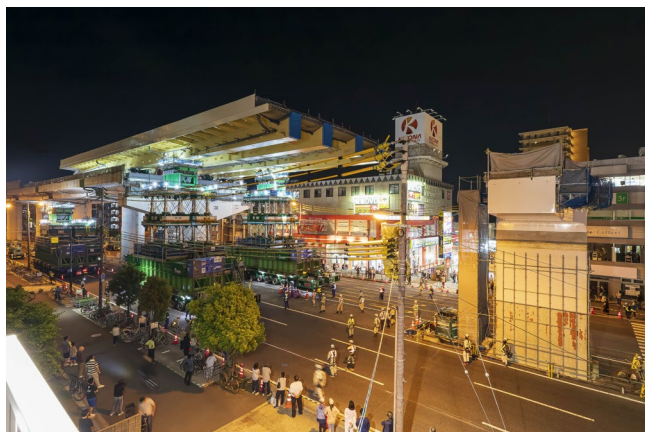
鋼製箱桁 / 側径間部の送出し
