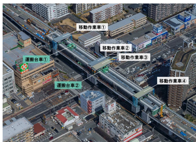
PC 箱桁撤去時の状況
