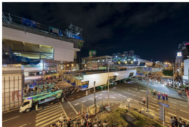
鋼製箱桁 / 中央径間部の吊上げ
