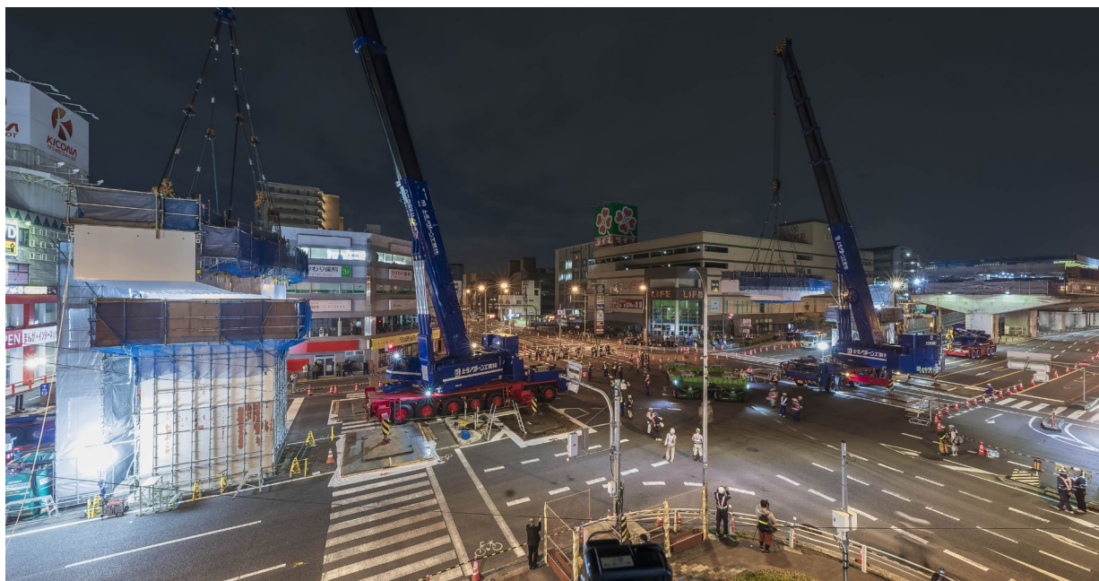
鋼製梁の架設状況
