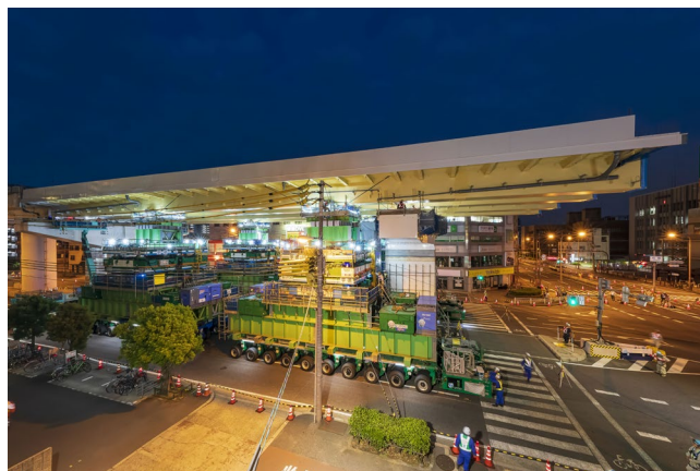
鋼製箱桁 / 側径間部の橋脚への受替え
