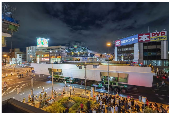
鋼製箱桁 / 中央径間部の運搬
