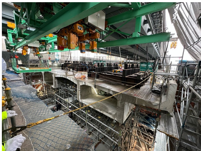
PC 箱桁の切断面
