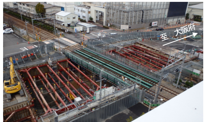
▲御園工区 平成30年 JR線地下施工状況
