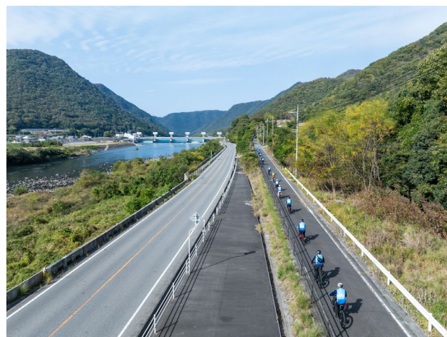
トライアルライド（第4期総会） 岡山県和気郡和気町（片鉄ロマン街道ルート）
