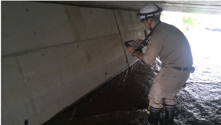
タブレット端末を利用した点検状況とタブレット画面例
