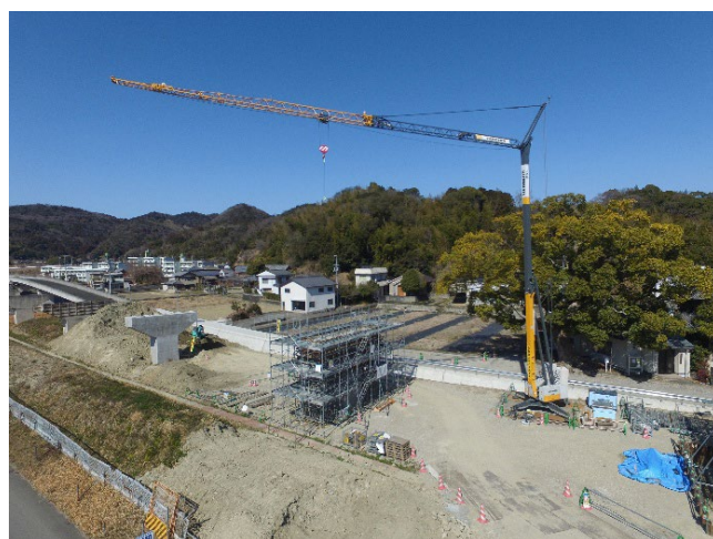
写真-2 定置式水平ジブクレーンを活用した作業状況
