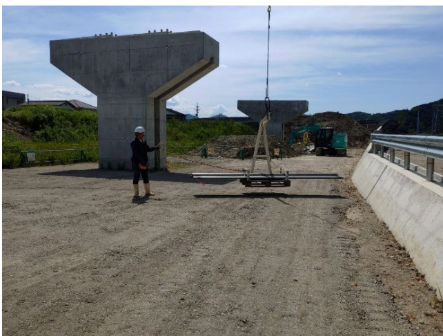
写真-5 長尺専用枠の活用例
