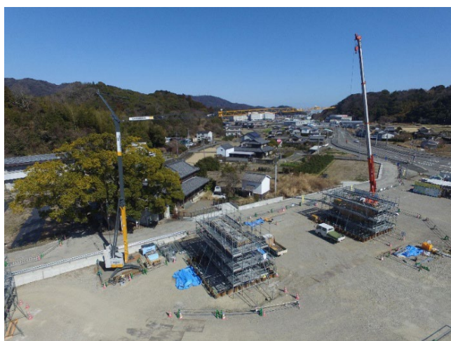
写真-2 定置式水平ジブクレーンを活用した作業状況
