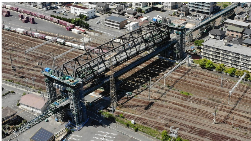
写真1 現在の古川跨線橋（トラス橋）の状況
