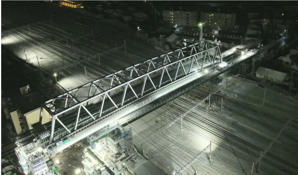
写真 2 深夜作業中の現場写真
