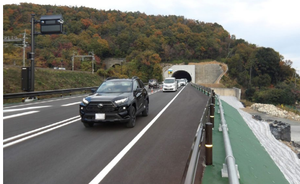
開通した小松拡幅
