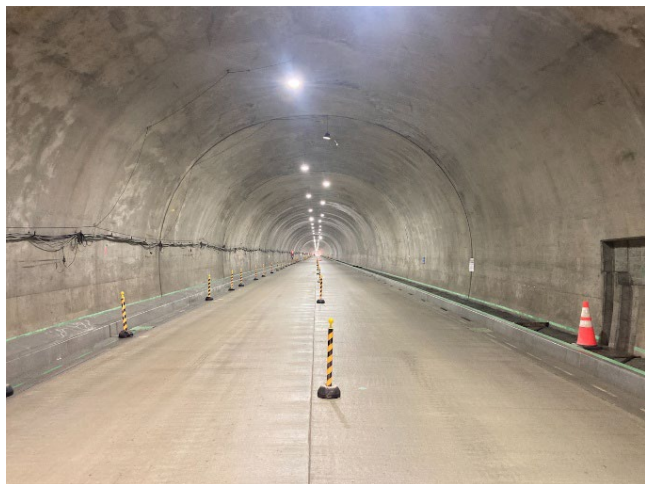
写真－1 トンネル区間施工状況
