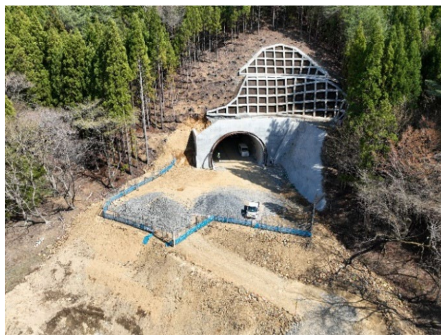
写真－4 小積浜工区施工状況
