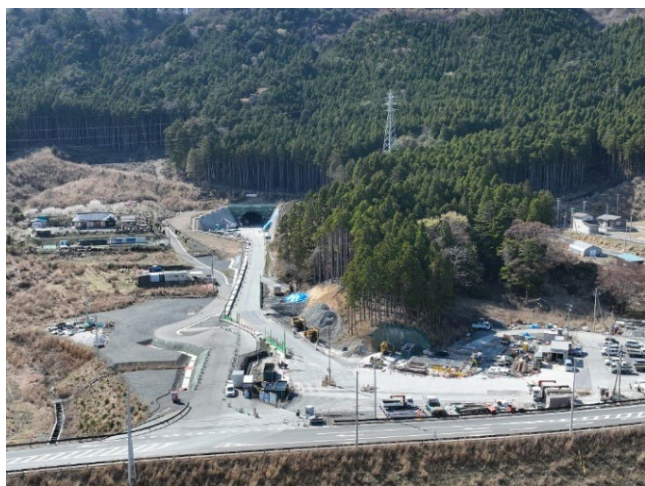
写真－3 大谷川浜工区施工状況
