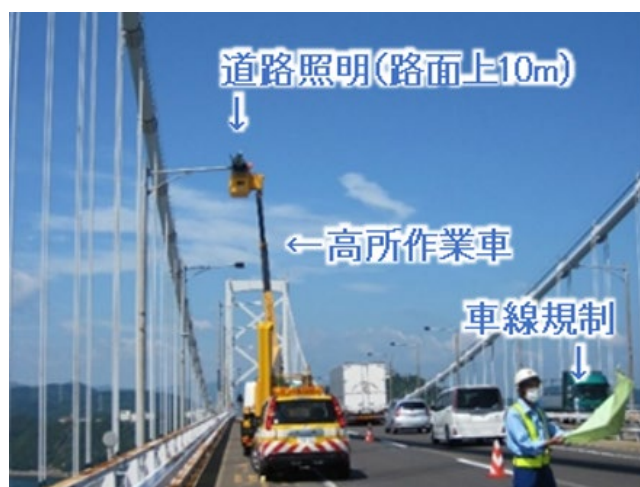
写真-2 ポール照明のメンテナンス状況
