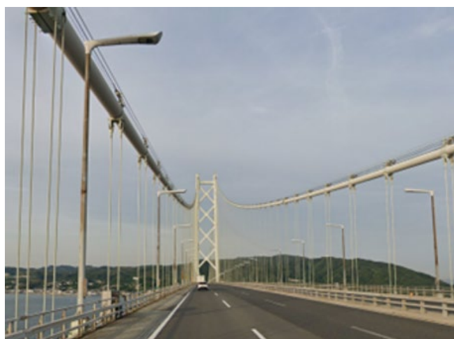
写真-1 ポール照明
