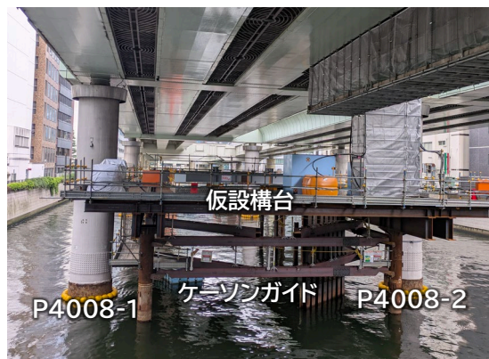
図-7 仮受4008 施工状況
