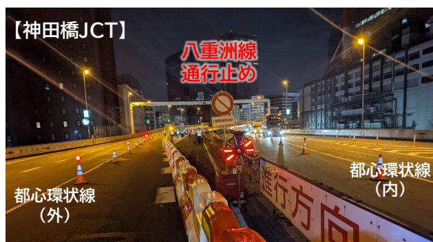
図-9 八重洲線通行止め（神田橋 JCT 閉塞部）
