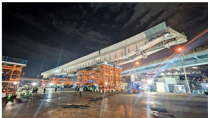
図-15 桁一括架設の状況（入口部）
